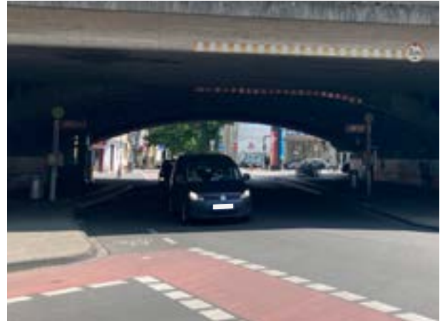
ÖPNV-Knotenpunkt an der Liebigstraße/Quartierseingang S-Bahnhof Köln-Nippes
