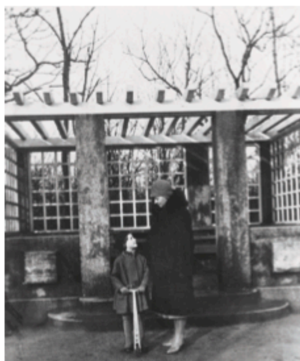
Das Unterstandshäuschen bekommt ein neues Dach.
